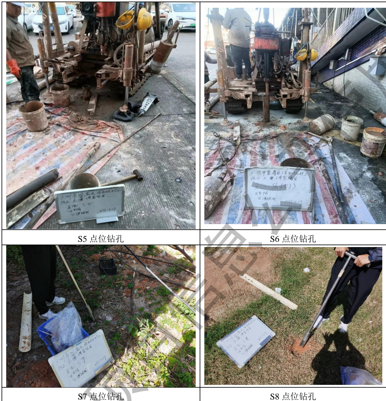
图 4.2-1 现场钻探作业过程照片
