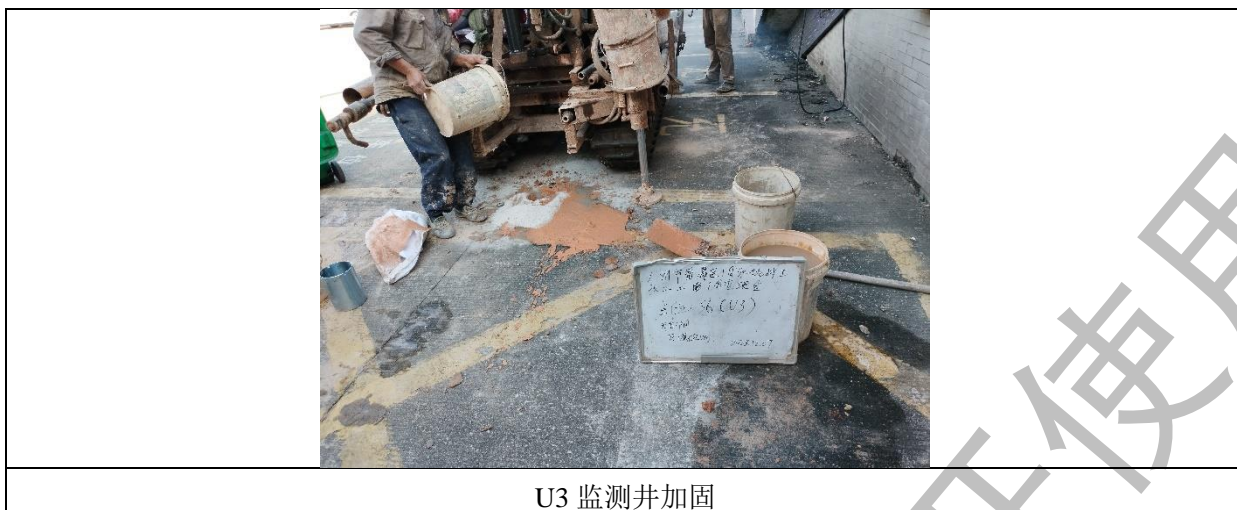
图 4.2-5 地下水监测井建井作业过程照片
